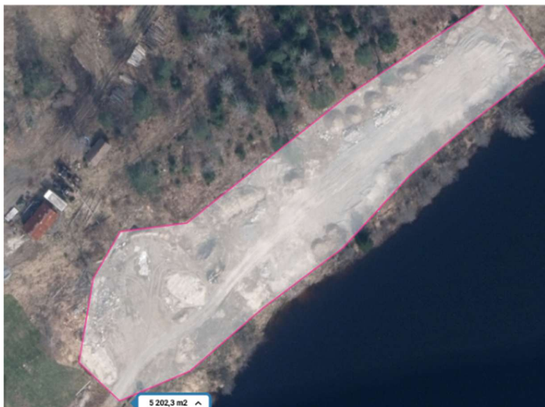
Bild 11. Ett ca 0,5 ha stort område där schaktningsarbeten genomförts. Den ursprungliga matjorden bedöms ha schaktats bort och lagts i högar. Fyllnadsmassor har sedan ersatt Jorden.
