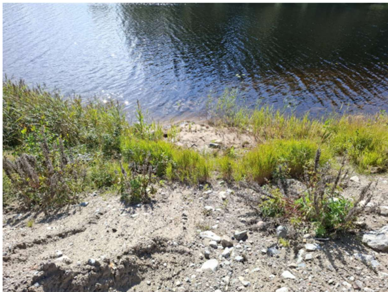
Bild 18. På ett ställe hade omfattande erosion skett på massorna, och eroderat material kan ses i vattnet.
