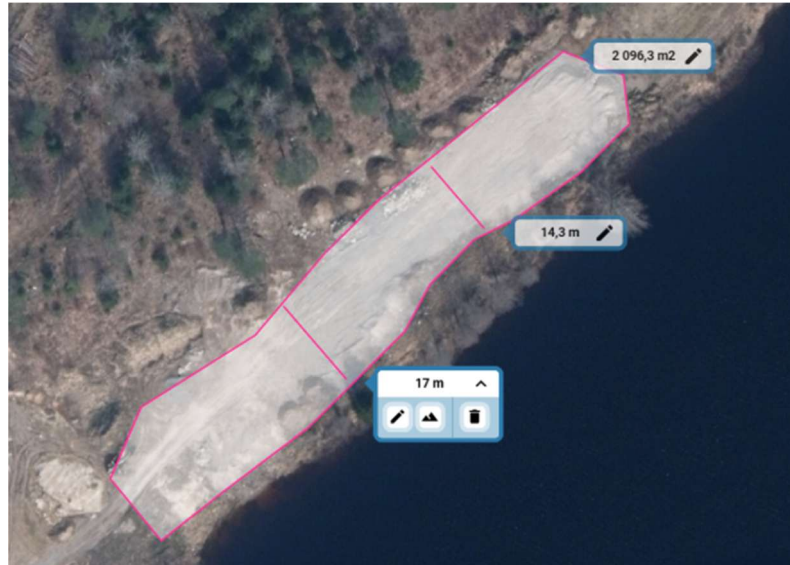
Bild 12. Det är svårt att avgöra volymen av eventuellt förorenade massor, men de täcker ca 2000 m 2 . Vid kanten ut mot vattnet är höjden ca 1,7 m och den genomsnittliga bredden ca 15 m. Den genomsnittliga höjden bör därmed vara ca 0,75 m x 2 000 m 2 , dvs ca 1500 m 3 .
