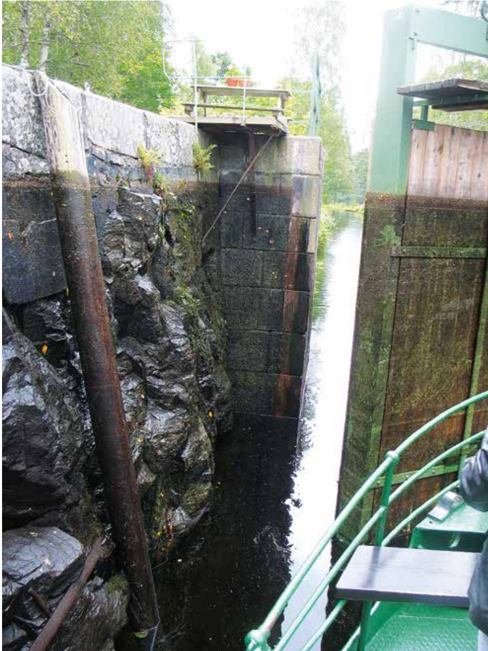
Hösten 2000 var det rekordhøgt vattenstånd i Dalslands kanal, men den 150 år gamla slussen höll © Foto: Renée Olsåker
